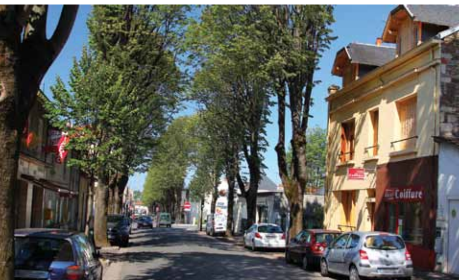
LA RÉFECTION DE LA NOUVELLE PORTION DU BD DE L'HÔPITAL, ENTRE LA RAMPE VOLTAIRE ET LA RUE DE CHÂTEAUDUN, S'ACHÈVE
